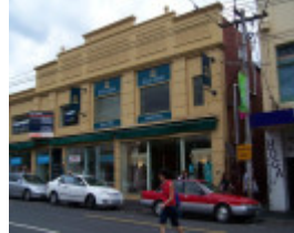
Bridge Rd 173-179 6332.JPG
