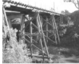
Site 012 - Arundel Road Trestle Bridge.jpg
