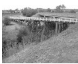
Site 012 - Trestle Bridhge - Arundel Road bridge.jpg
