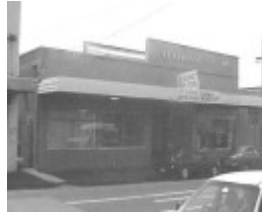
Site 095 - St Albans Public Hall.jpg
