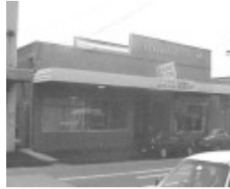
Site 095 - St Albans Public Hall.jpg
