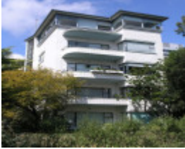
NEWBURN FLATS SOHE 2008
