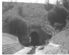
Site 019 - Steele Crk Rail embankment.jpg
