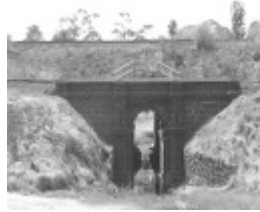
Site 027 - Black Arch Rail bridge.jpg
