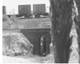
Site 027 - Black Arch Rail bridge (2).jpg
