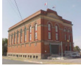
Site 003 - Albion VR, DC sub station (2).jpg
