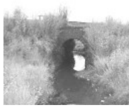
Site 028 - Railway culvet.jpg
