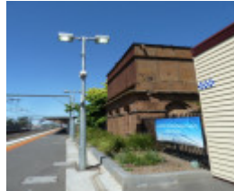
H1673 WATER TOWER LHA 2015 1.JPG
