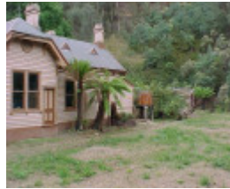
H00583 walhalla po exterior7 mar 2003
