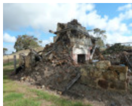
H0281 TARNDWARNCOORT HOMESTEAD LHA 2015 6.JPG
