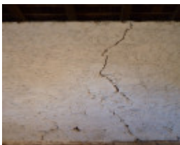
H0281 TARNDWARNCOORT HOMESTEAD LHA 2015 5.JPG
