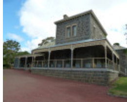
H0281 TARNDWARNCOORT HOMESTEAD LHA 2015 1.JPG
