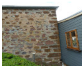
H0281 TARNDWARNCOORT HOMESTEAD LHA 2015 3.JPG
