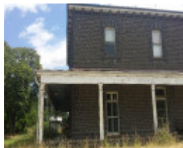
Ingleby Southern Elevation 2016.jpg
