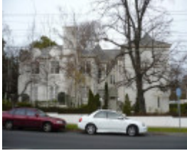
Gradsden Hall Flats
