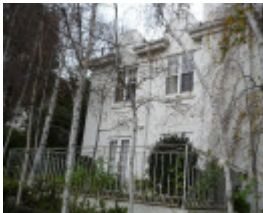
Gradsden Hall Flats
