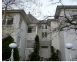
Gradsden Hall Flats
