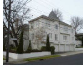
Gradsden Hall Flats
