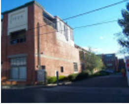
RICHMOND YORK STREET 31 Unit 1.jpg
