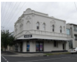
Buckley St 187.JPG
