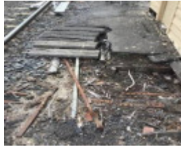
remnant interlocking equip signal box.jpg
