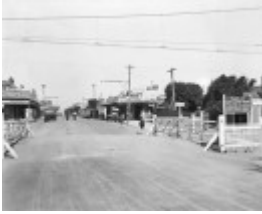
Bell St coburg.jpg
