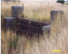
23282 Bluestone Weir Nth Byaduk 0638
