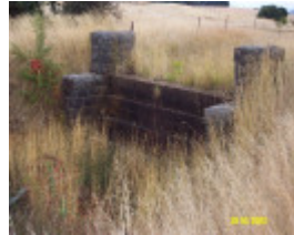
23282 Bluestone Weir Nth Byaduk 0639
