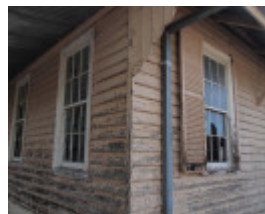
H1570 KOONDROOK TRAM COMPLEX LHA 2015 4.JPG
