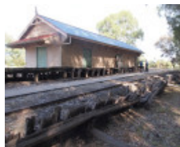
H1570 KOONDROOK TRAM COMPLEX LHA 2015 5.JPG
