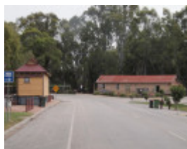
H1570 KOONDROOK TRAM COMPLEX LHA 2015 1.JPG
