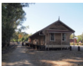
H1570 KOONDROOK TRAM COMPLEX LHA 2015 3.JPG
