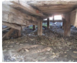
H1570 KOONDROOK TRAM COMPLEX LHA 2015 8.JPG
