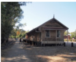
H1570 KOONDROOK TRAM COMPLEX LHA 2015 3.JPG
