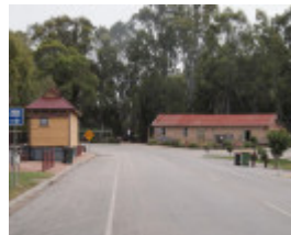
H1570 KOONDROOK TRAM COMPLEX LHA 2015 1.JPG
