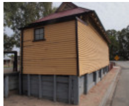
H1570 KOONDROOK TRAM COMPLEX LHA 2015 2.JPG
