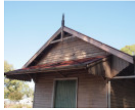
H1570 KOONDROOK TRAM COMPLEX LHA 2015 7.JPG
