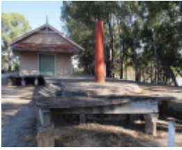
H1570 KOONDROOK TRAM COMPLEX LHA 2015 6.JPG
