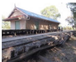
H1570 KOONDROOK TRAM COMPLEX LHA 2015 5.JPG
