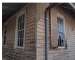
H1570 KOONDROOK TRAM COMPLEX LHA 2015 4.JPG
