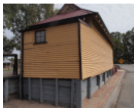
H1570 KOONDROOK TRAM COMPLEX LHA 2015 2.JPG
