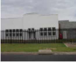
HO17 - F.T.Wimble & Co, 13-21 Annesley Street, Braybrook.JPG
