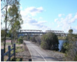
HO146(1) - Angliss Stock Bridge 1.jpg
