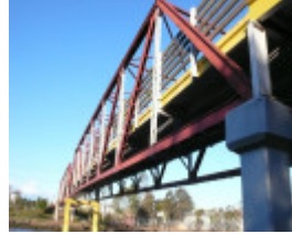
HO146(2) - Angliss Stock Bridge 2.jpg
