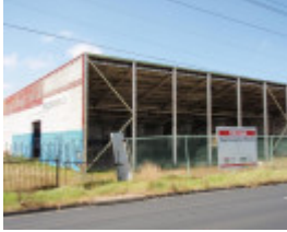
HO83(1) - Eta Factory, 254 Ballarat Road, Braybrook.JPG
