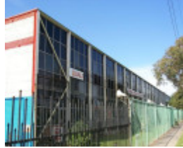
HO83(3) - Eta Factory, 254 Ballarat Road, Braybrook.JPG
