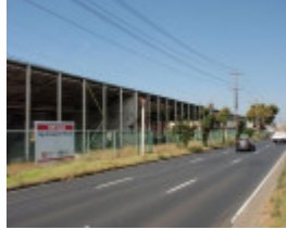
HO83(2) - Eta Factory, 254 Ballara Road, Braybrook.JPG
