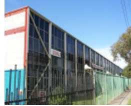
HO83(3) - Eta Factory, 254 Ballarat Road, Braybrook.JPG
