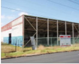
HO83(1) - Eta Factory, 254 Ballarat Road, Braybrook.JPG
