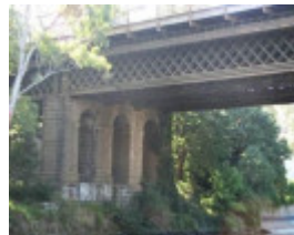
Hawthorn Bridge (1861) (VHR H0050).jpg
