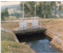
HO2 Pipe 2.jpg
