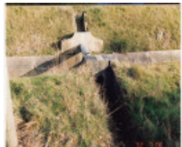
HO2 Pipe 6.jpg
