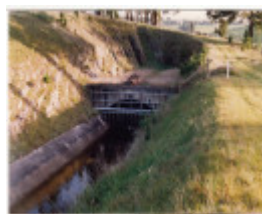
HO2 Pipe 4.jpg
