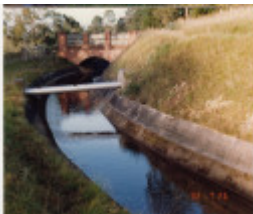
HO2 Pipe 5.jpg
