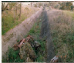
HO2 Pipe 11.jpg
