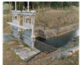
HO2 Pipe 3.jpg
