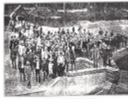
HO2 Pipe Opening.jpg
