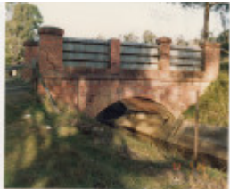
HO2 Pipe 8.jpg
