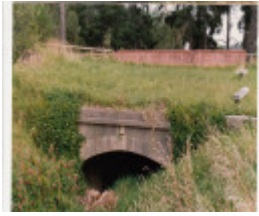
HO2 Pipe 9.jpg
