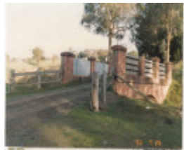
HO2 Pipe 7.jpg
