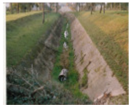
HO2 Pipe 10.jpg
