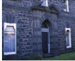
d'estaville kew detail of stone entrance
