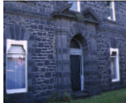
d'estaville kew detail of stone entrance
