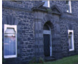
d'estaville kew detail of stone entrance
