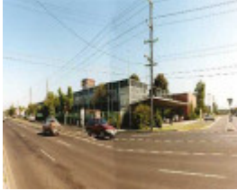
B5435 ETA Factory
