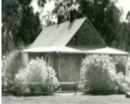
B1644 Schwerkolt's Cottage
