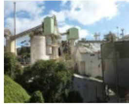
Site view 2017.jpg
