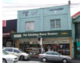
Bridge Rd 191-193.JPG
